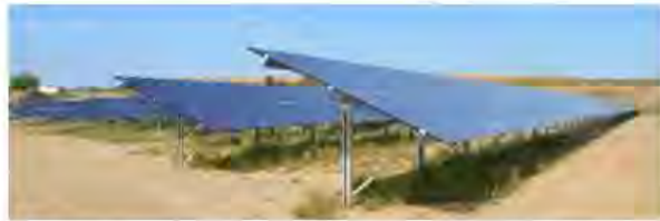
Structures fixes orientées vers le Sud
